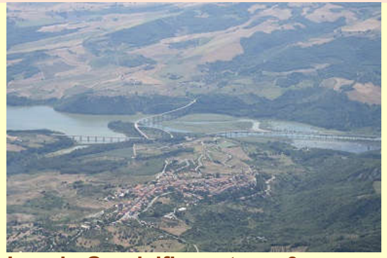
Lac de Guadalfiera et ses 3 viaducs convergeants
